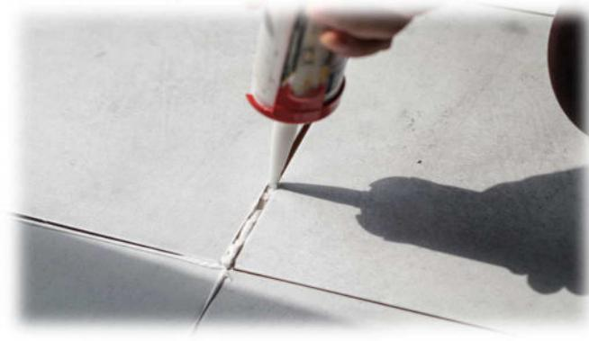
**MS-CRISTAL** est un mastic-colle qui s'applique sur tous supports, même détrempé. Couvrant un spectre de collages pratiquement universel, présentant une bonne résistance aux intempéries et au vieillissement, ayant les qualités suivantes :
